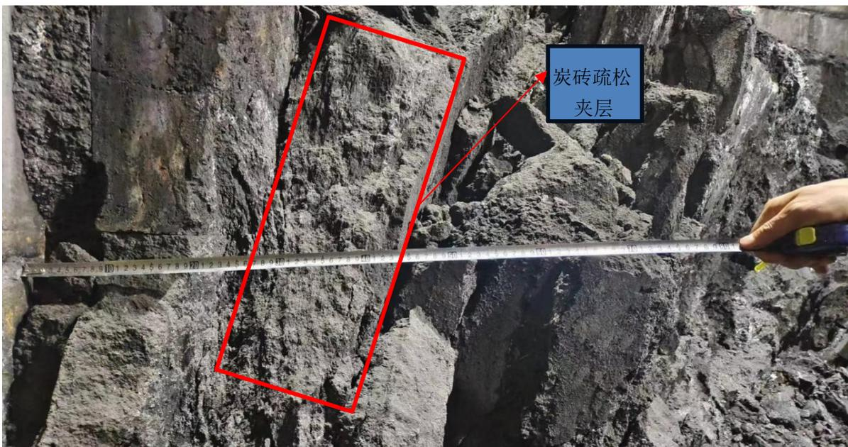
图 2 事故高炉炉缸南侧环向疏松夹层
